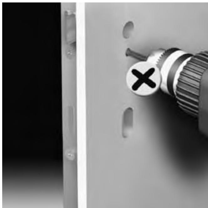
Das Türblatt darf im Schlossbereich nicht bei eingebauter Verriegelung (z. B. für Schutzbeschläge) durchgebohrt werden.
