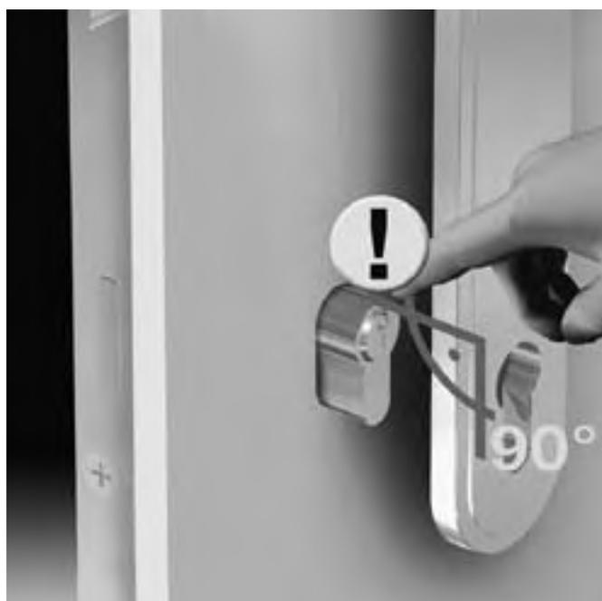
Langschilder und Rosetten spannungsfrei montieren.
